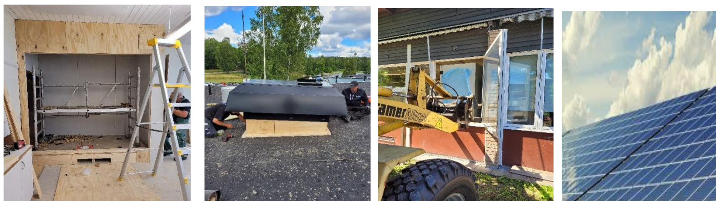
Bilder från renoveringsarbetet.
